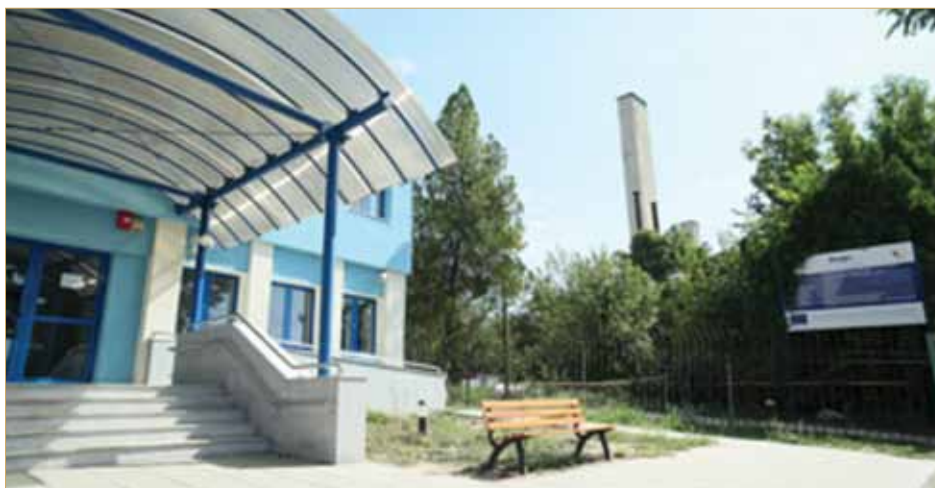
Reabilitarea, modernizarea și echiparea Ambulatoriului Integrat al Spitalului Județean de Urgență Călărași
