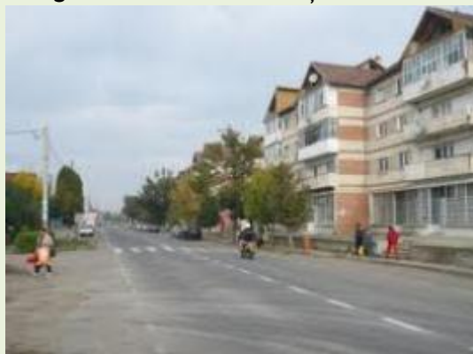
Reabilitare arteră principală - Buhuși
