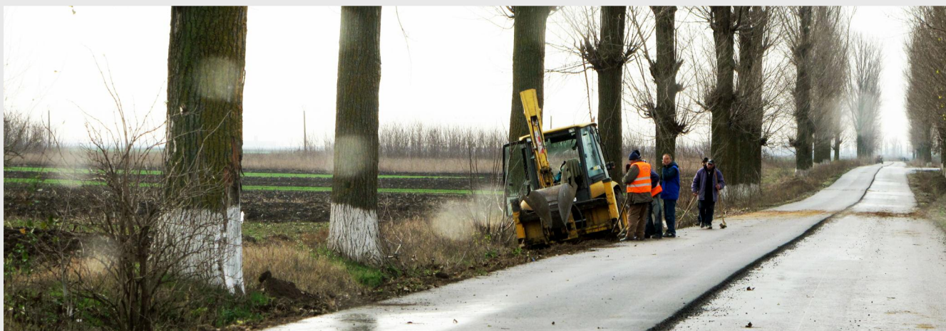
DJ 201 (foto arhivă ADR Muntenia)
