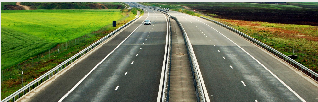
Autostrada A1, București - Ploiești
